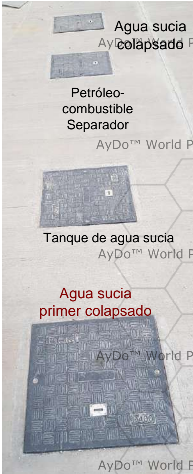
Tanques subterráneos de agua sucia
