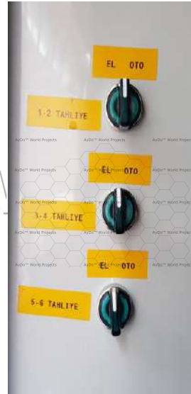
Vaciado de Tanques de descanso
